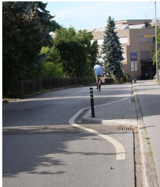
Abb. III.1.21 Verschwenkung
